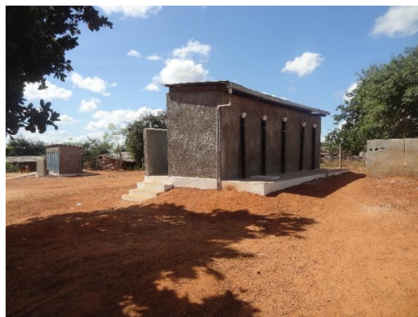
Figura 12: Sanitários da Escola Secundária. Fonte: Autores (2017)
